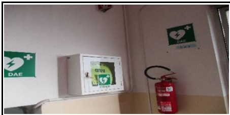
INGRESSO PALESTRA PIANO PRIMO
